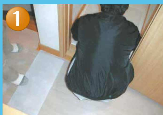
養生ボード敷き
