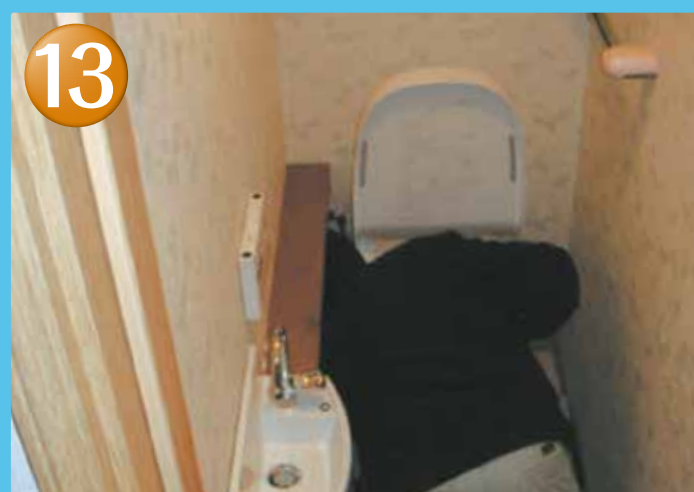
洗剤タンク取付け
