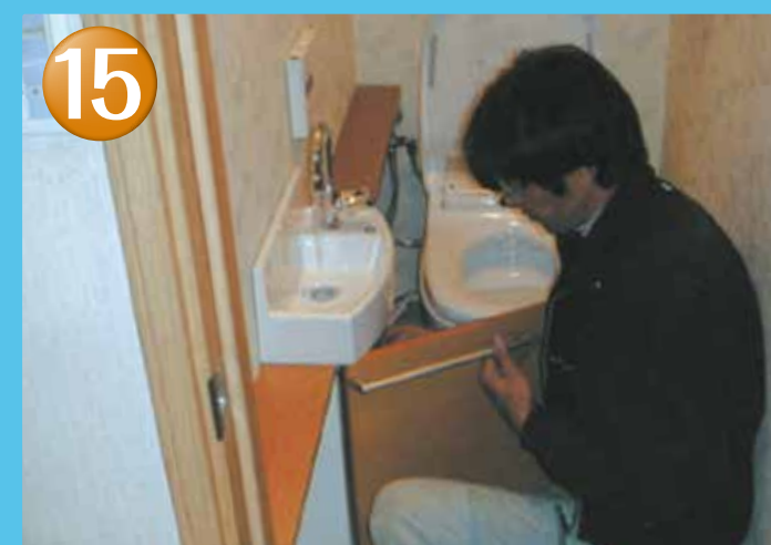
漏水検査
