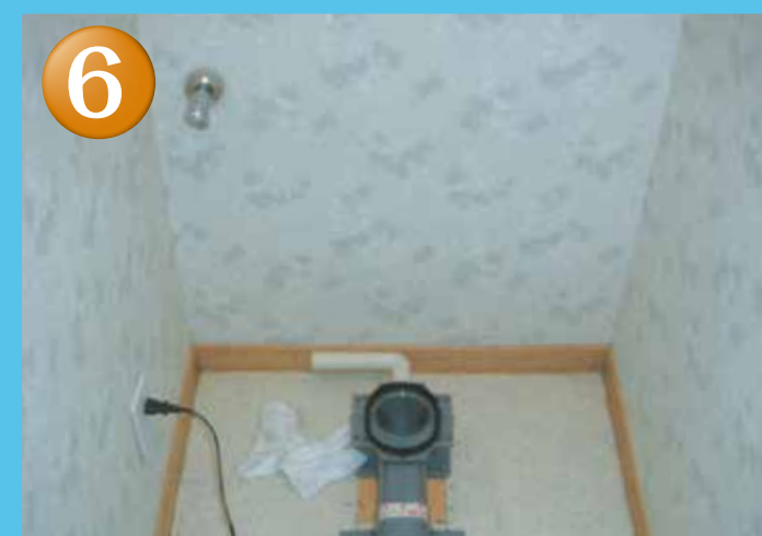
止水栓取り替え・水道を開く
