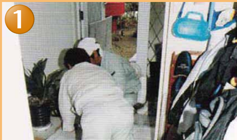
養生ボード敷き
