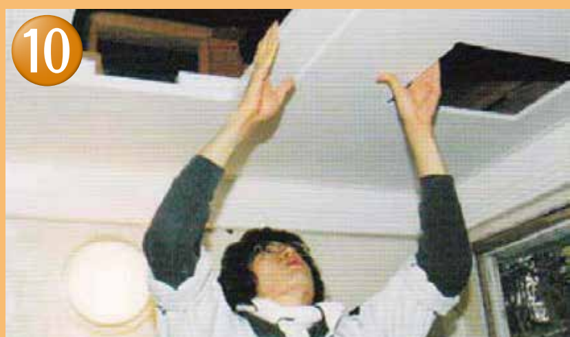
組立て据付工事
