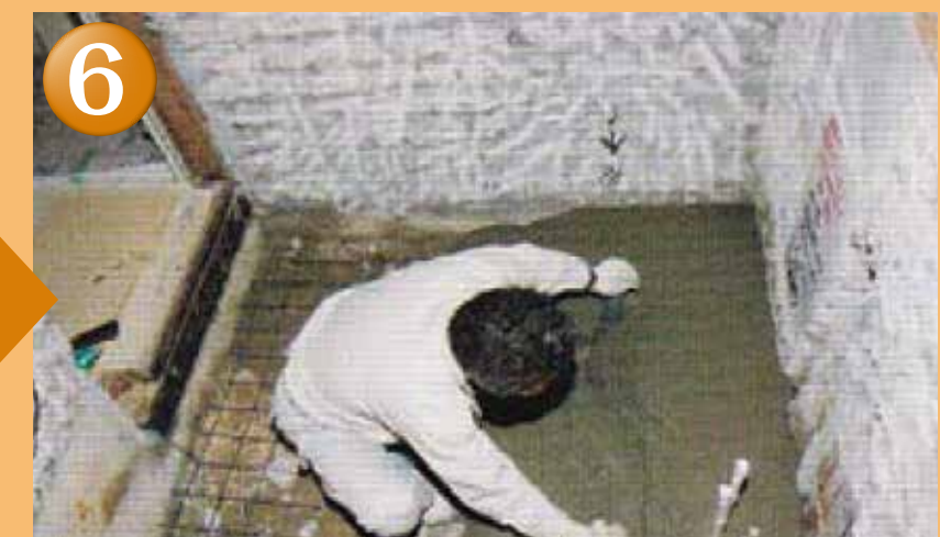
土間基礎工事
